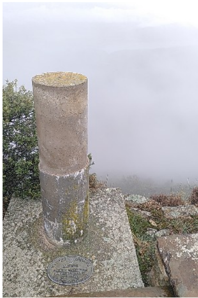
Le repère géodésique de ce point élevé avec sa plaque bien compréhensible
