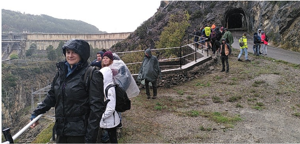
Joli point de vue sur le barrage, malgré la pluie
